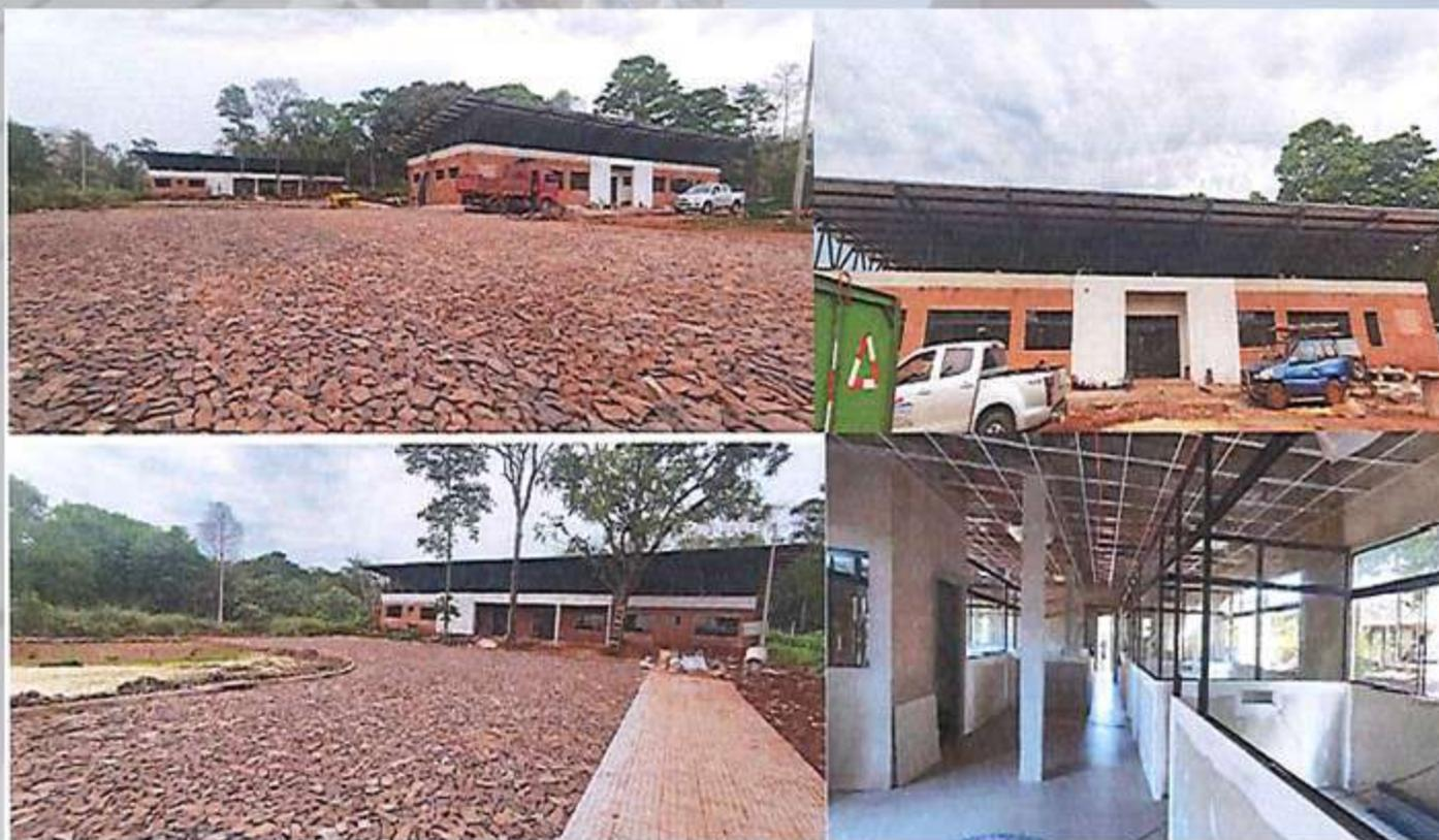
Continuación de la construcción de un nivel para oficinas y el habitacional con sus áreas de apoyo correspondiente, baños, patio de maniobra de empedrado para camiones y estacionamientos para vehículos.
